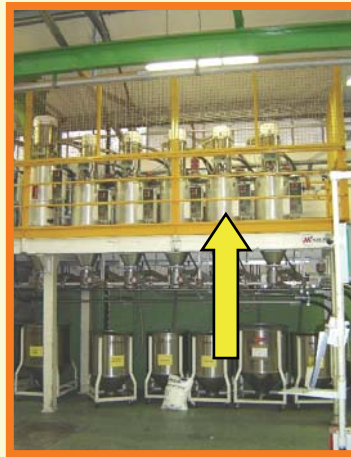
Remplissage des cuves
